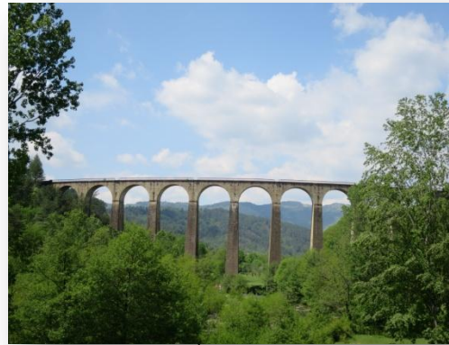
Viaduc de Chamborigaud
